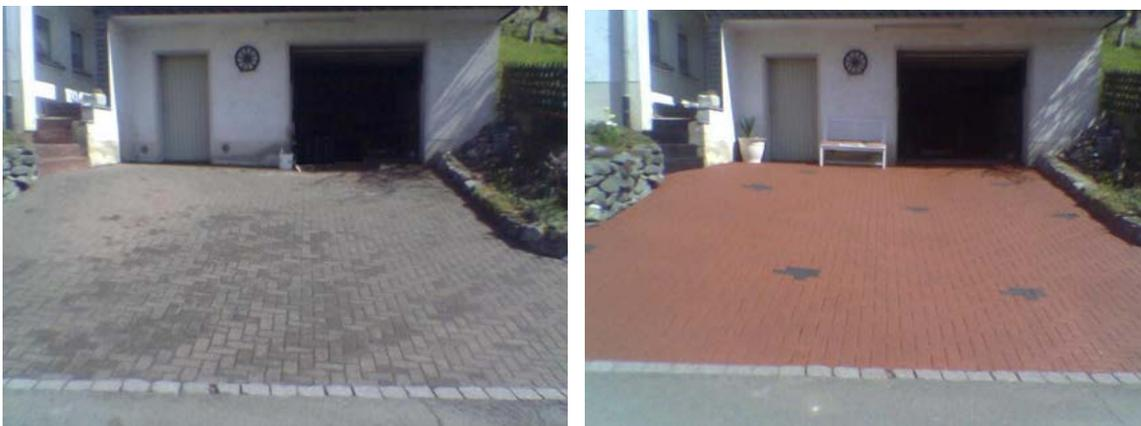
Hier sieht man eine Garageneinfahrt die zum Zeitpunkt der Sanierung 18 Jahre alt war. Diese Fläche wurde gereinigt, und mit ISOPAINT NORDIC A/S Stonecolor bearbeitet bzw. beschichtet.
