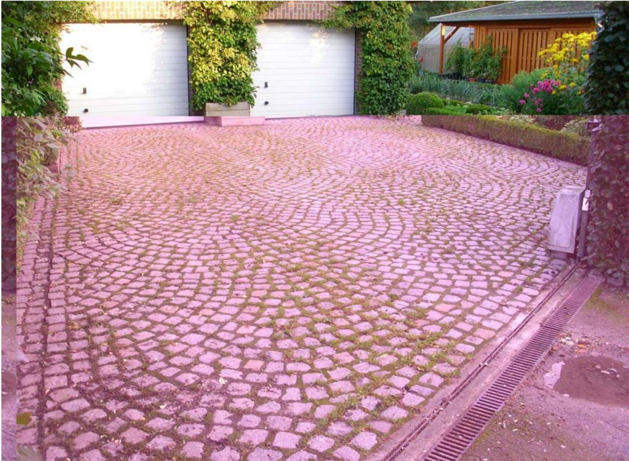
In diesem Fall greift man auf die Reinigung durch Druckluft zurück. Mit einem speziellem Bodengerät und einem 5m<sup>3</sup> Baukompressor, wird das Fugenmaterial ausgeblasen und (fast) trocken entfernt.
