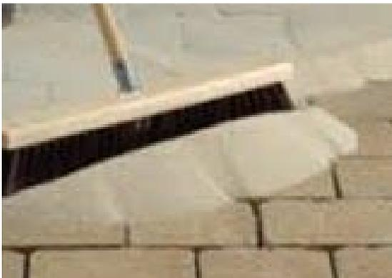
Feuchter Sand lässt sich nicht gut verarbeiten! Kehren Sie anschließend das Material immer diagonal und sorgfältig in die Fugen.
